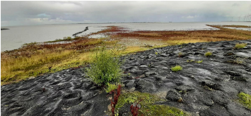
HAVEN DELFZIJL ANNO 2024 MET RECHTSBOVEN DE WINDMOLENS OP DE PIER
